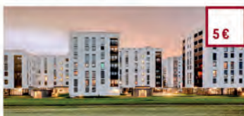
Rum Steinbockallee, Passivhaus Plus 132 Mietwohnungen, davon 33 5-Euro-Wohnungen und 20 als betreubare Wohnungen
