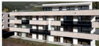
Telfs Südtiroler Siedlung, 3. BA 36 Miet- und 28 Eigentumswohnungen
